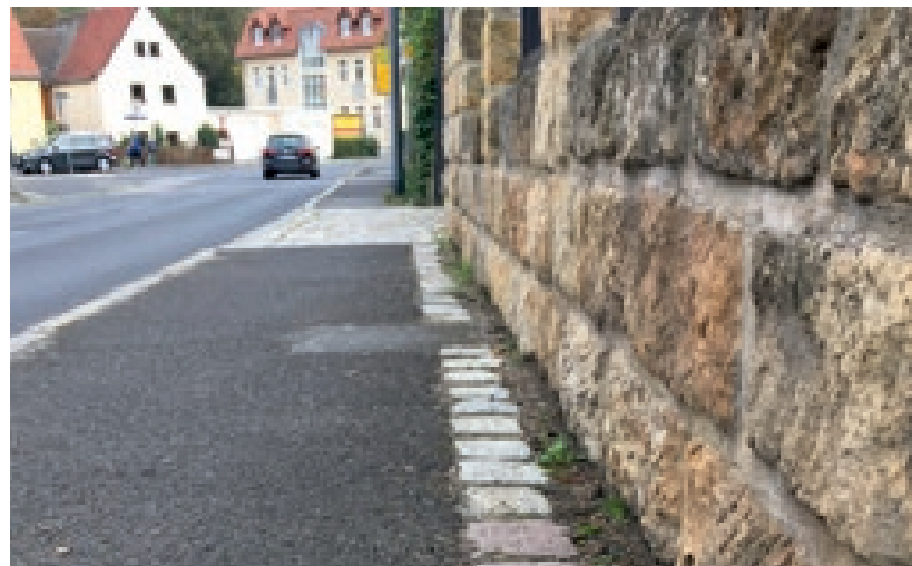
Anordnung einer Pflasterreihe als Gehwegrücklage
