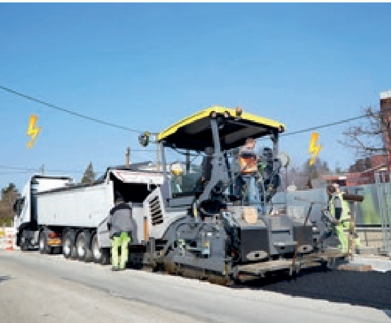
Thermoisoliertes Transportfahrzeug mit Abschiebefunktion im Einsatz unter Oberleitungen
