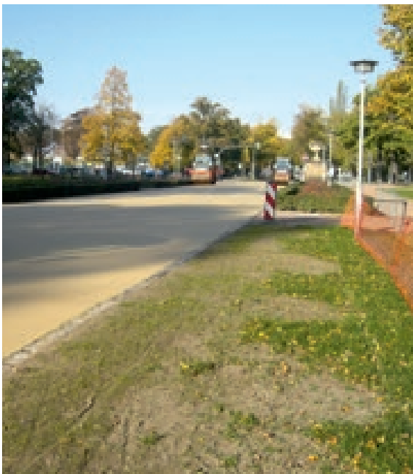
Einbau von farbigem Asphalt im Großen Garten Dresden
