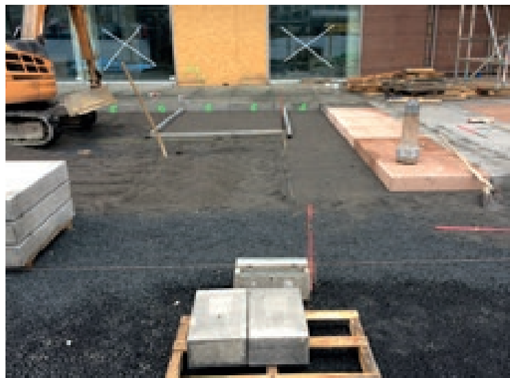
Beispiel der Ausführung Großformatiger Plattenbeläge auf Wasserdurchlässiger Asphalttragschicht PA 22 T WDA
