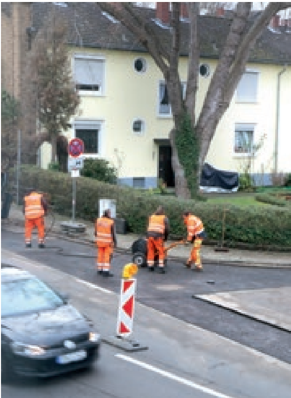
Verschließen einer Aufgrabung
