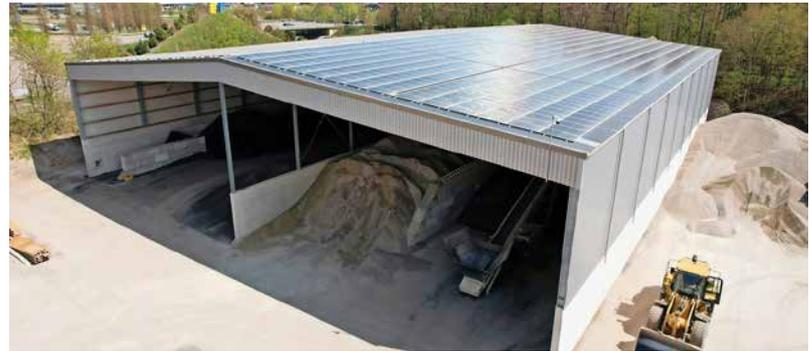
Länge: 60,00 m, Breite: 50,00 m, Spannweite: 2 x 25,00 m, Traufhöhe: 11,79 m, Photovoltaik-Leistung: 300 kWp
