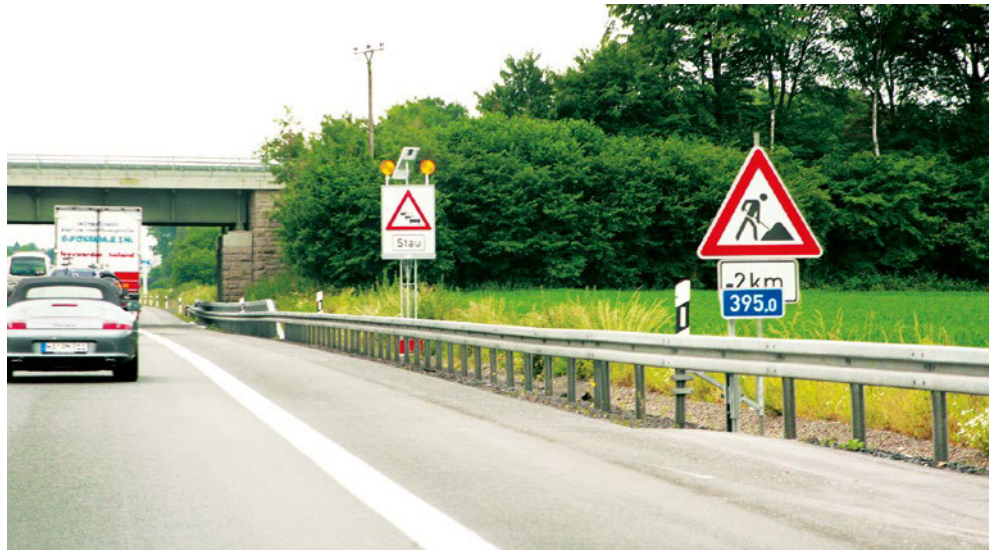
Sichere (?) Anbringung eines Verkehrszeichens an ein FRS.
