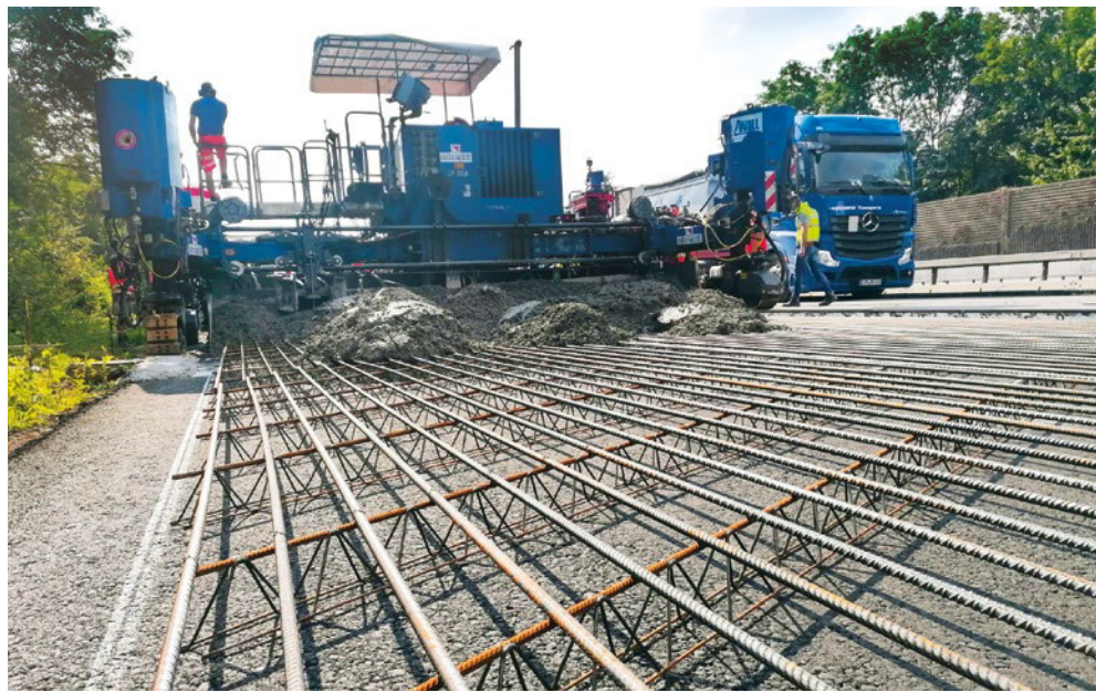
Die Abbildung zeigt die Herstellung der Versuchsstrecke A61 bei Boppard im Juli 2021.
