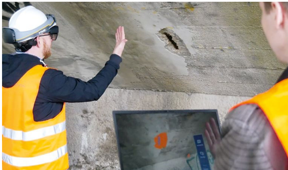
Demonstrator beim Test an einer Brücke.
