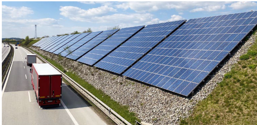
PV-Lärmschutzwall an der A 94 bei Töging.
